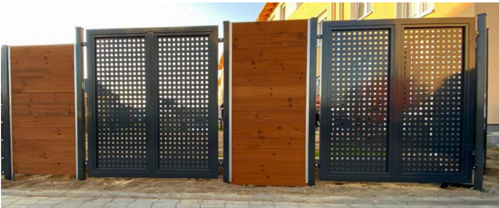
Zaun mit Lochblechfüllung und Holz-Elementen (bauseits)
