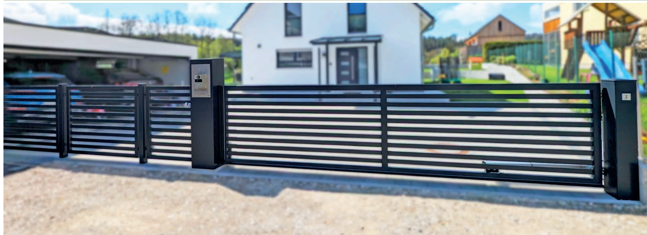
elektrische Toranlage mit Kommunikationssäule
